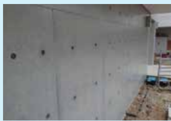
施工事例①
