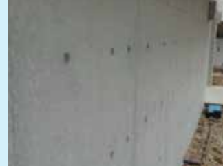
施工事例②
